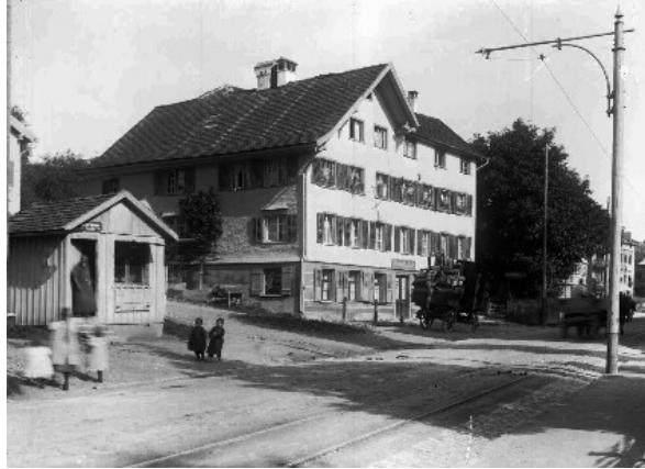
Ehem. Rest. Rössli, Langgasse 5, 9008 St. Gallen (vor 1909),
